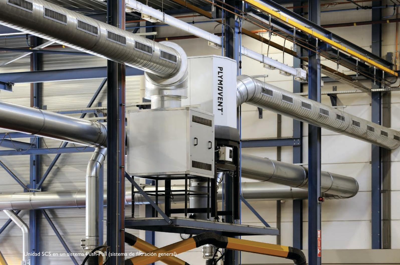
Unidad SCS en un sistema Push-Pull (sistema de filtración general)
